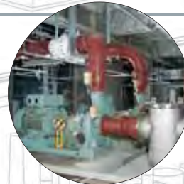
硬質塩化ビニルライニング鋼管・継手 施工現場
