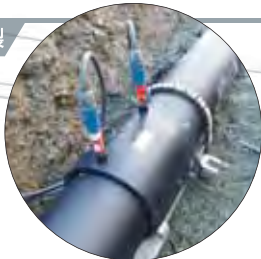
アイボリーブロードパイプ EF接合 施工現場
