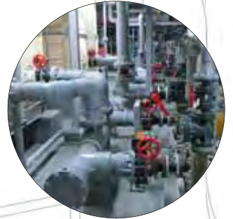
水族館 施工現場
