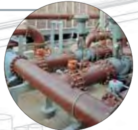
硬質塩化ビニルライニング鋼管・継手 施工現場
