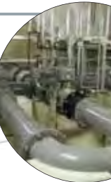
ナイロンコーティング鋼管・継手 施工現場
