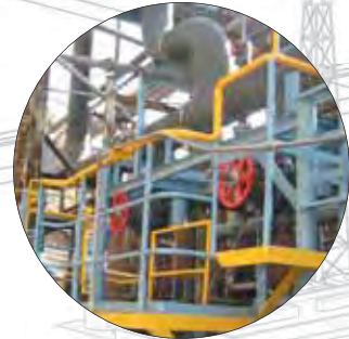
ケミカルプロセス 施工現場
