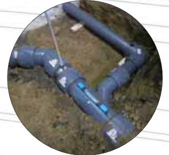
フジPPパイプ 施工現場
