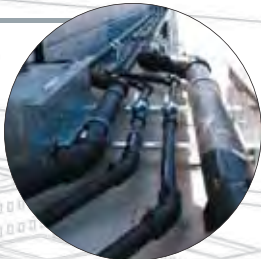
アイボリーブロードパイプ 融雪・消雪配管 施工現場
