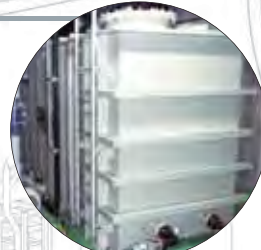
PP製タンク 処理設備 施工現場
