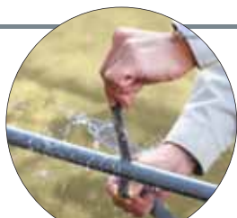
シリコンゴムテープ 水漏れ御用 漏水補修現場
