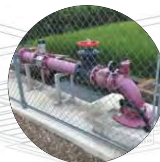
用水路 施工現場
