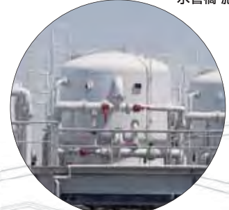
浄水場 施工現場
