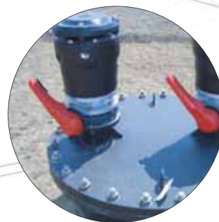
農水パイプライン 施工現場
