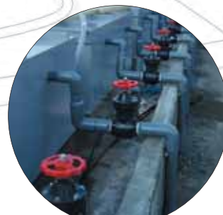
水産・養殖場 施工現場
