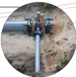
農水パイプライン スポンジMジョイント 施工現場
