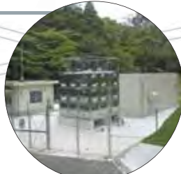
ステンレスパネルタンク 貯水配水槽 施工現場
