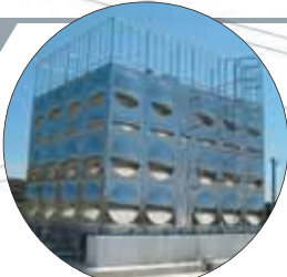
ステンレスパネルタンク (産業用) 施工現場
