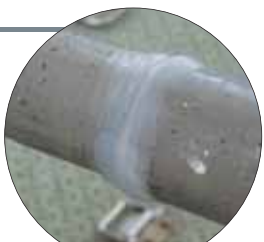
腐食防止用シリコンテープ ねじ部 サビ御用補修現場
