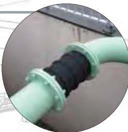
ゴム可とう伸縮継手 アトムジョイント施工現場
