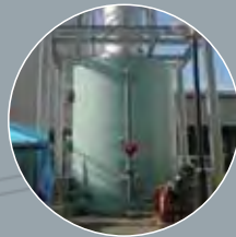
FRP脱臭塔 施工現場
