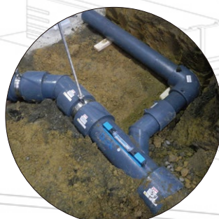
フジPPパイプ 施工現場
