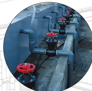
水産・養殖場 施工現場
