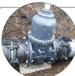
農水バイブライン スッポンMジョイント バルブ取り替え工事現場
