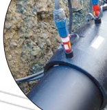
アイボリーブロードパイプ EF接合 施工現場
