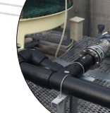
圧力用高密度ポリエチレンパイプ 冷却水配管 施工現場
