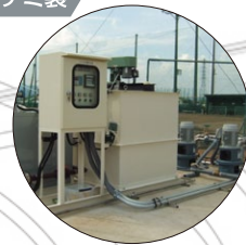
連続式pH中和装置 TPC型 施工現場
