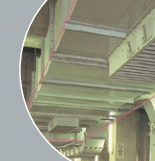
工業用硬質塩化ビニル押出板 廃液処理槽(角ダクト・吹出口) 施工現場
