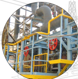
ケミカルプロセス 施工現場
