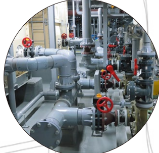
水族館 施工現場
