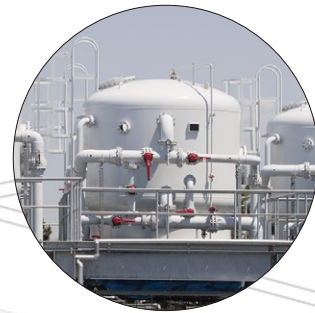
浄水場 施工現場
