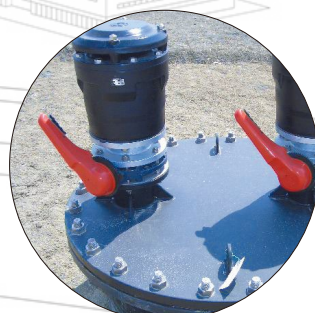
農水パイプライン 施工現場
