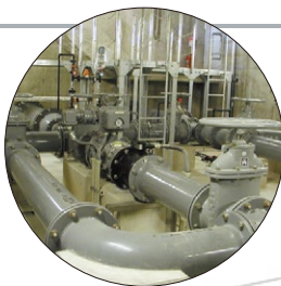
ナイロンコーティング鋼管・継手 施工現場
