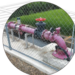
用水路 施工現場
