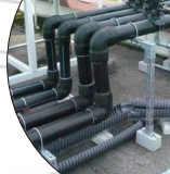
圧力用高密度ポリエチレンパイプ 露出配管 施工現場
