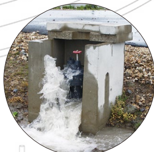
田んぼへの自動給水 自動給水栓 施工現場
