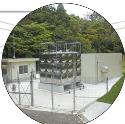
ステンレスパネルタンク 貯水配水槽 施工現場
