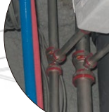
ステンレス鋼管 KKベスト 施工現場
