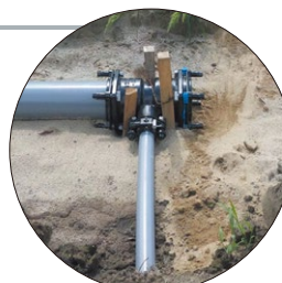
農水バイブライン スッポンMジョイント 施工現場
