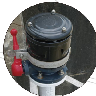
水管橋 施工現場
