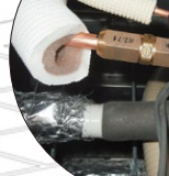
新冷媒HFC 用継手 おっぞんくんB 施工現場
