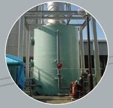
FRP脱臭塔 施工現場
